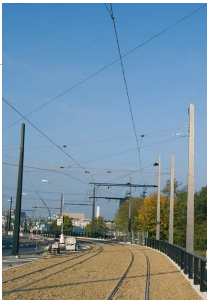
Doppelspur an Querspanner mit Beiseil
