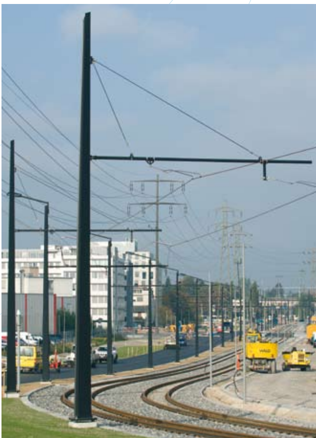
Fliegende Spurhaltung im Gleisbogen an Ausleger
