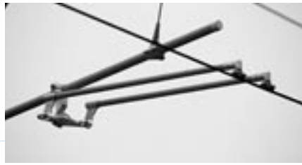
Spurhalter mit Fahrdrahtklemmen, einfach oder doppelt
