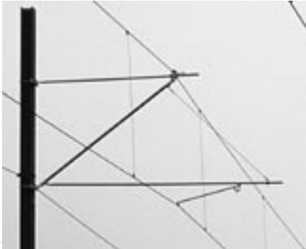
Auslegergeometrie mit horizontaler Verstellmöglichkeit
