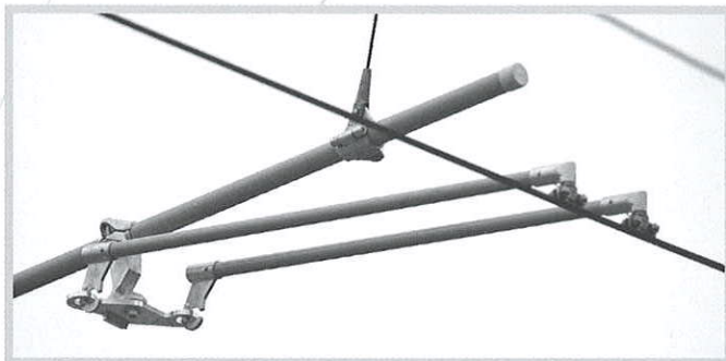
Bras de retenue simple ou double avec pinces de fil de contact
