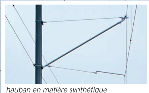
ancrage volant du bras de retenu
