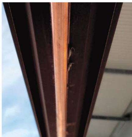
Profil mit eingezogenem Fahrdraht ohne überflüssige Fettrückstände.
