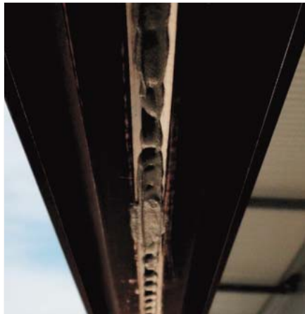
Apport de graisse dans la fente du profilé.
