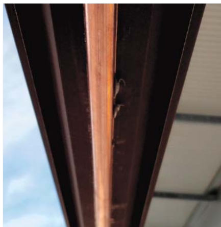
Profilé avec fil de contact en place sans résidus de graisse inutiles.
