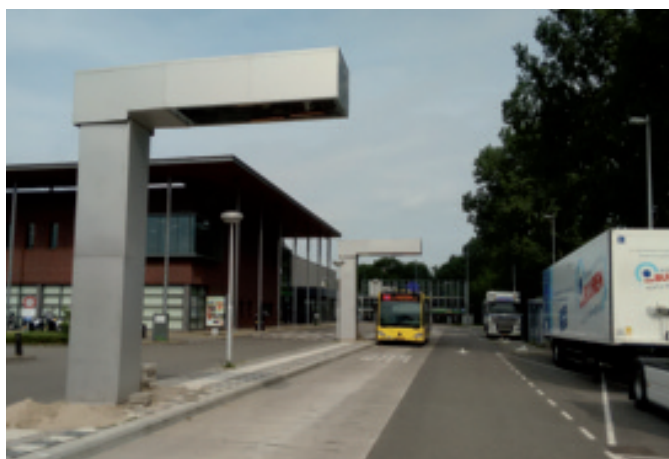
Zwei Ladestationen von Furrer+Frey in Edelstahloptik im niederländischen Utrecht (links). Rechts eine Detailaufnahme des Stromabnehmers während des Ladevorgangs. Auf dem Busdach befinden sich die in Längsrichtung angeordneten Kontaktschienen mit vernickelter Kontaktfläche. Um einen soliden Kontakt auch mit aktiver Kneelingfunktion zu gewährleisten, sind die Kontaktschienen leicht abgerundet. Neben den Kontakten für Plus- und Minuspol wird mittels eines dritten Kontakts das Erdpotential der Ladestation mit dem Buschassis verbunden. Ein zusätzlicher vierter Kontakt dient der Verifizierung der Erdverbindung. Für den Betrieb unter winterlichen Bedingungen können die Kontaktschienen zudem beheizt werden.
