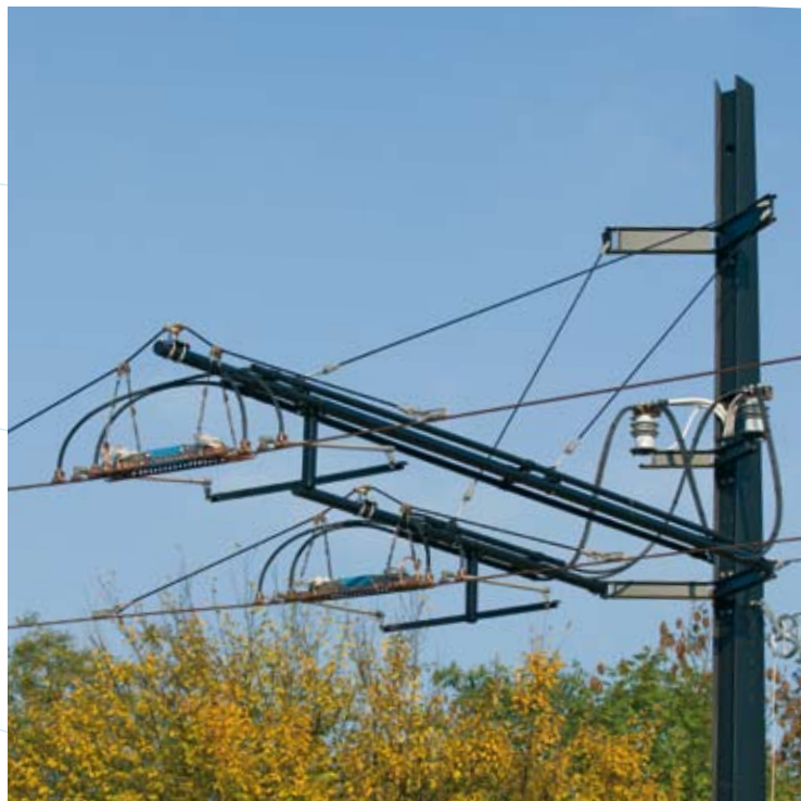
Séparation électrique avec quatre points d'alimentation
